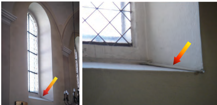
Bild 6.2 Die unschädliche Ableitung von unvermeidlichem Kondensat an der Einfach-Verglasung war in den Kirchen der vergangenen Jahrhunderte geübte Praxis
