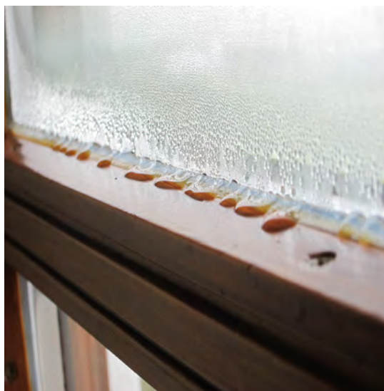
Bild 3.7 Beispiel für mögliche Kondensatmenge: Luft mit 23°C und 50% bei einer Oberflächentemperatur von 5°C können etwa 3g Kondensat je Kubikmeter vorbeistreichender Luft abgegeben werden.
